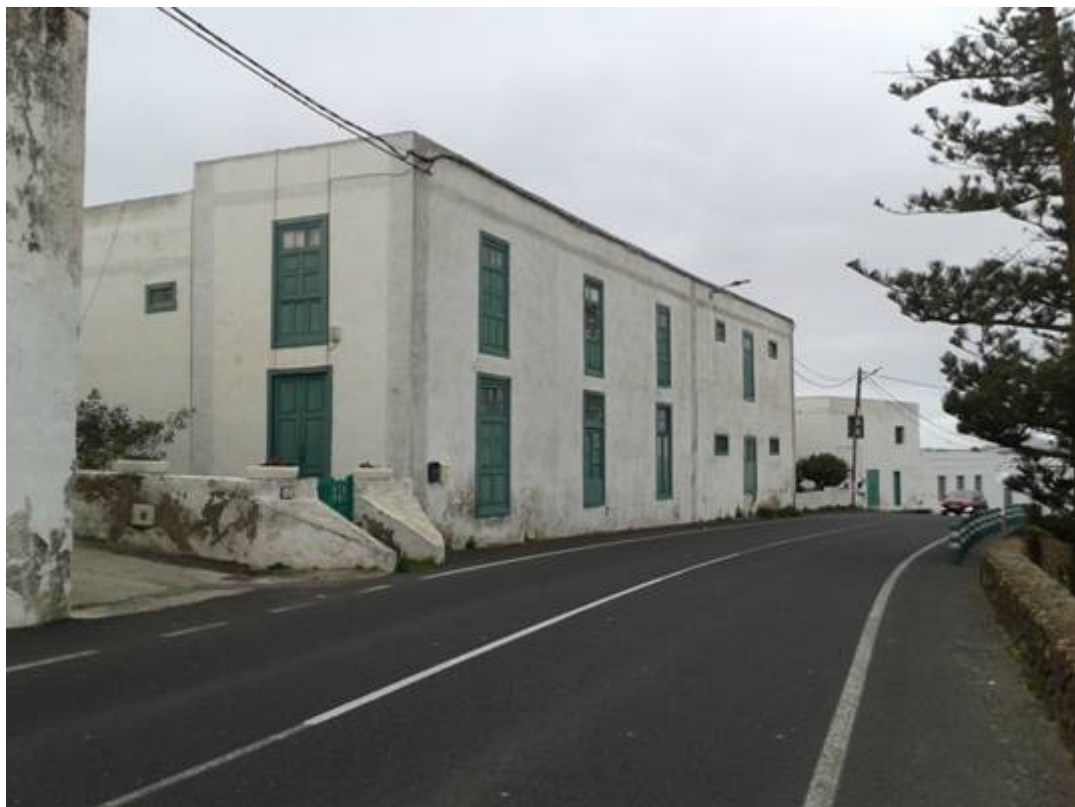
717. ENERGETIZACIÓN DE LA NUEVA SEDE DEL MUULATERIO DE TEGOYO (LANZAROTE)
