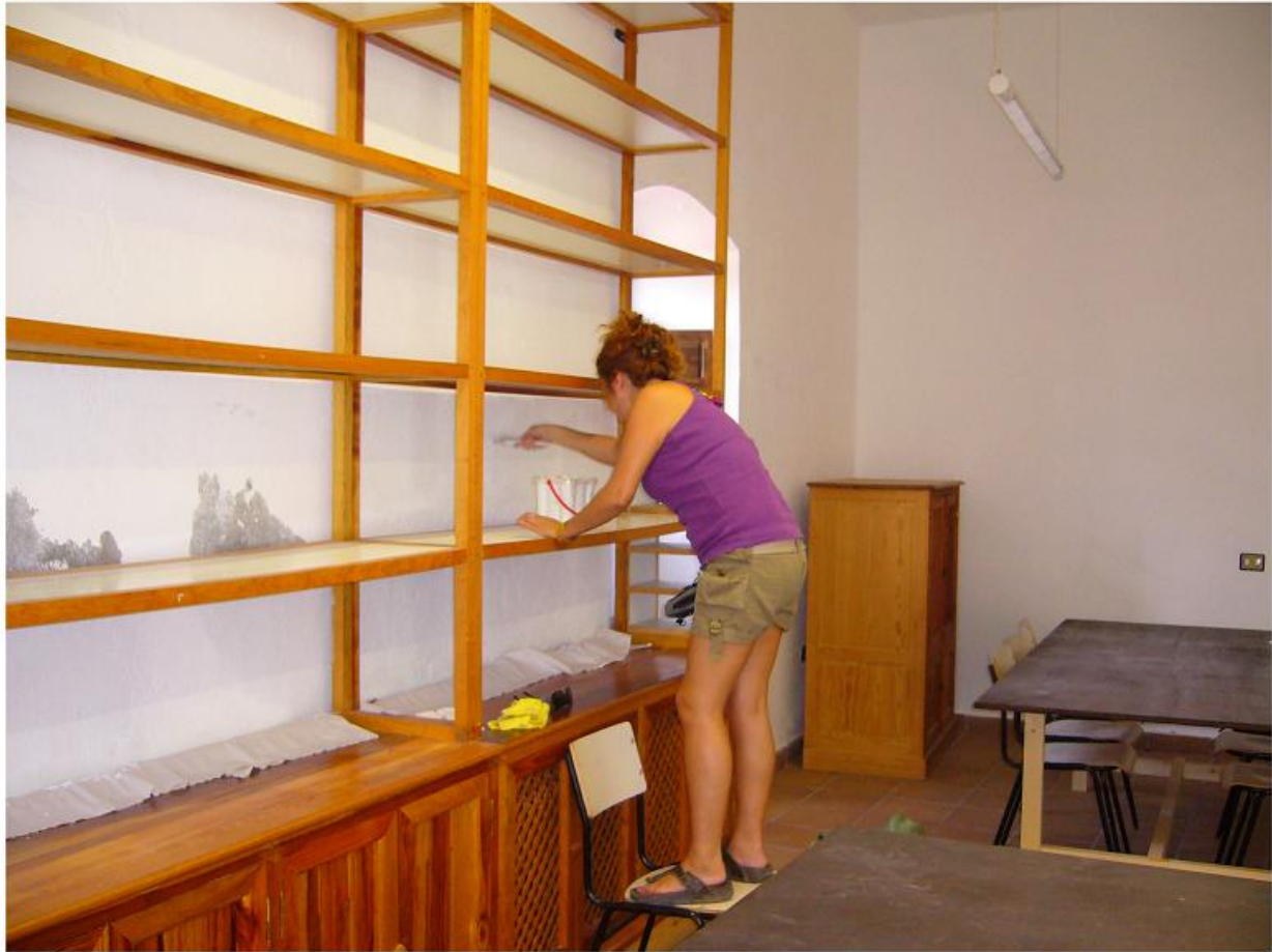
Limpieza y pintura
